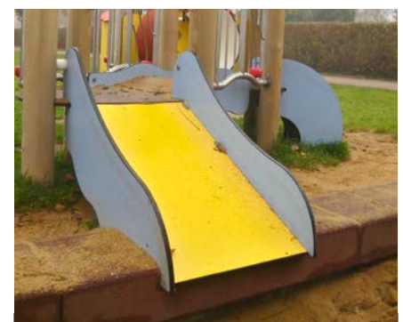
Das Rutschbrett ist so eingebaut, dass der „Auslauf“ in den Sandkasten erfolgt - jetzt stellt die Kante erhebliches Verletzungsrisiko für Kinder dar.
